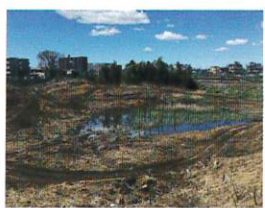
栄町土砂埋立工事 道路課、手賀沼課、市街地整備課他
