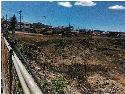
栄町一番地の伐採工事から特定事業工事へ（令和二年十月）
